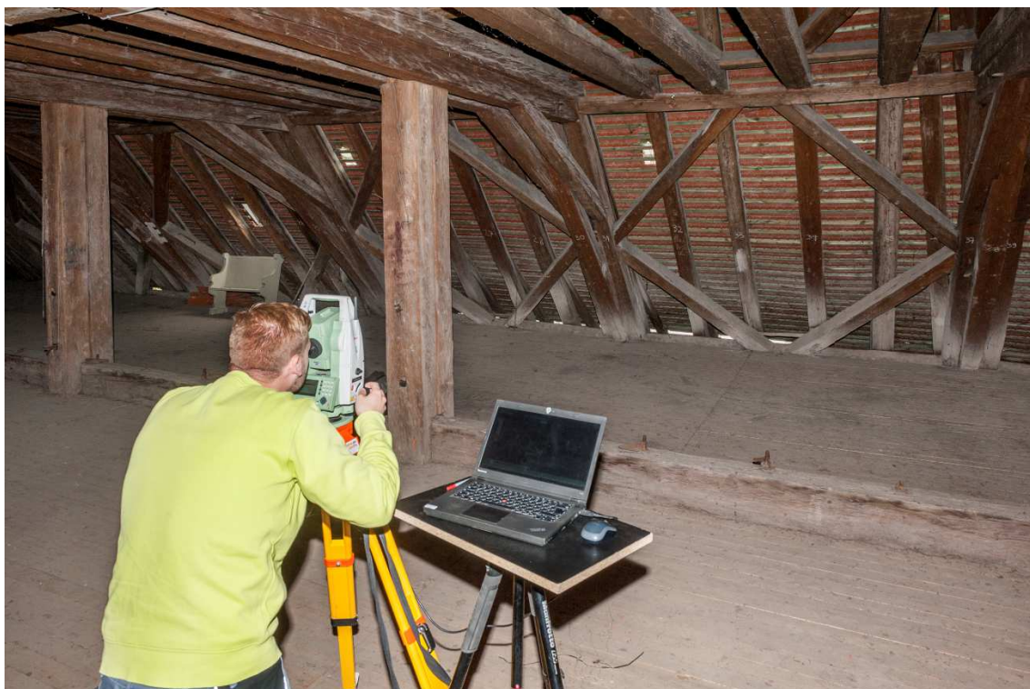
Tachymetrische Dokumentation im Dachstuhl der Kirche in Bad Wildbad
