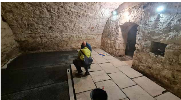
Gewölbe-Fußboden mit wiederverwendeten Natursteinplatten, Mittagstisch, Turmsanierung und Verfugung des Natursteinssockels an der Baustelle St. Johannes, Zuordnung Balusterfragmente Kloster Anrode
