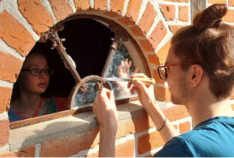
Fensterrestaurierung im Seminar in Lübeck
