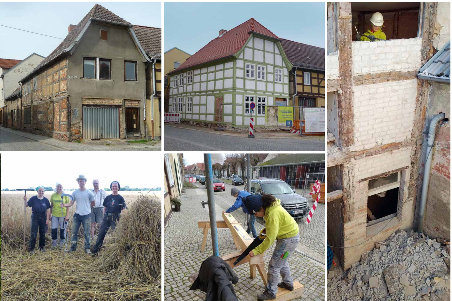
Stadtkontor vor und nach der Sanierung, Erntehelfer, Ausbau der Kalksandsteinausfachung,
