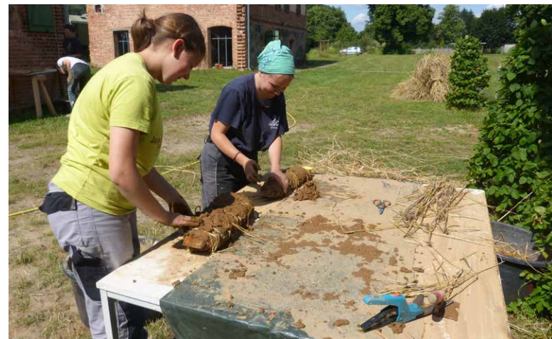
Herstellung Lehmwickelstaken
